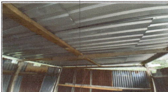
FOTO 2: TECHO: Sustitución de laminas por loza
